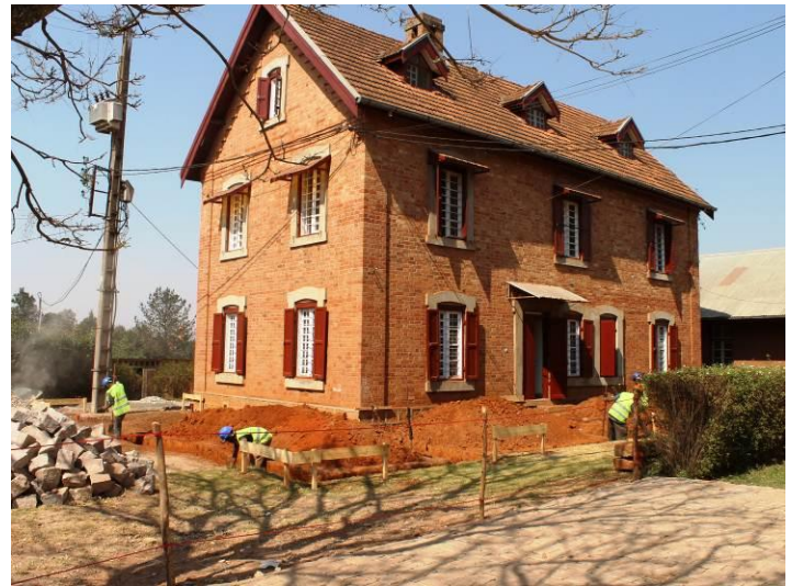
En har begynt på tilbygget ved det gamle amerikanerhuset. Foto: Kristoffer Hansen-Ekenes
