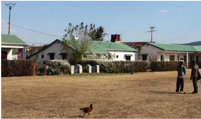
Bygningene på presteskolen Atsimoniavoko har fått nye tak. Foto: Arild M. Bakke
