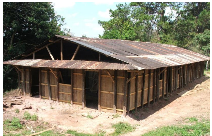
Bibelskolen i Ifanadiana under rehabilitering i 2008.
